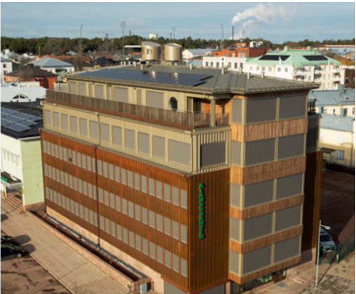
Kopparhuset från 1975 har fått två nya våningar.
